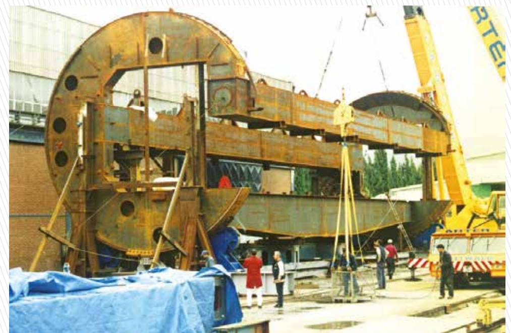
Erection of a Vagon Discharger Vagon Devirme Sistemi Montajı
